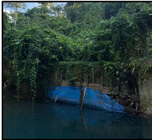
Gambar Kondisi Bendung/Dam Raksasa di Desa Kaana.
